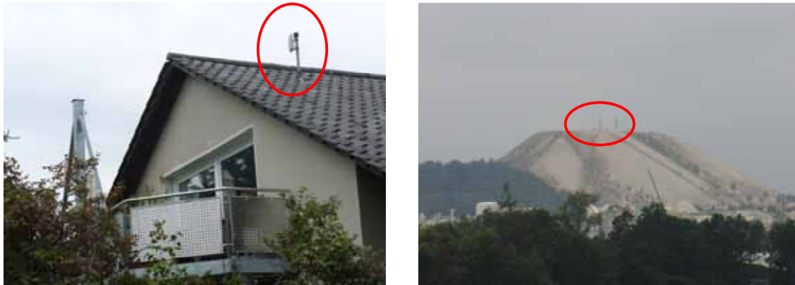
Bild 6.15: Auf dem Dach montierte Outdoor Unit (links) und dazugehörige Basisstation (rechts)
